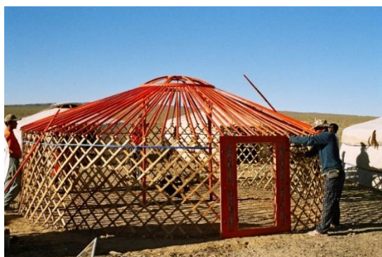
Gher mongola in costruzione
